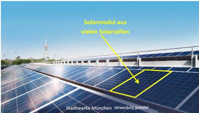
**Solarzellen** bauen die **Solarmodule** auf, die zu einer **Solaranlage** z. B. auf dem Dach einer Schule angeordnet werden. Dabei wird die **Sonnenenergie** direkt in **Strom umgewandelt**. Dieser kann ins Stromnetz eingespeist oder auch selbst verbraucht werden.
